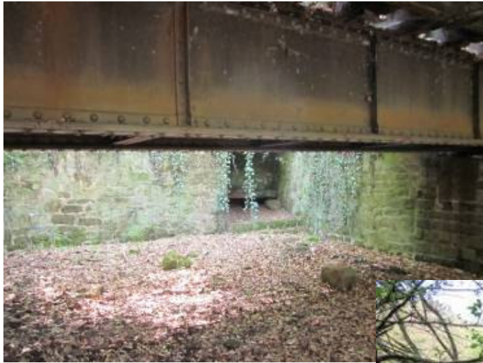
Ehemaliger historischer Waschplatz der Gemeinde Neuleiningen, der wieder hergerichtet werden soll.
